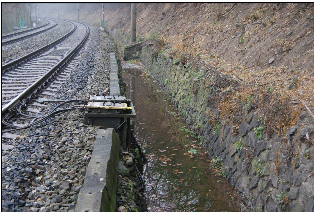
Stávající kamenný žlab u paty svahu.
